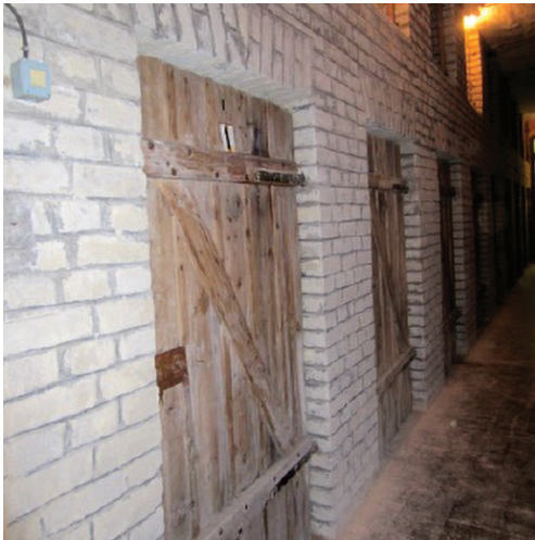
Casemate A- Le couloir en restauration
